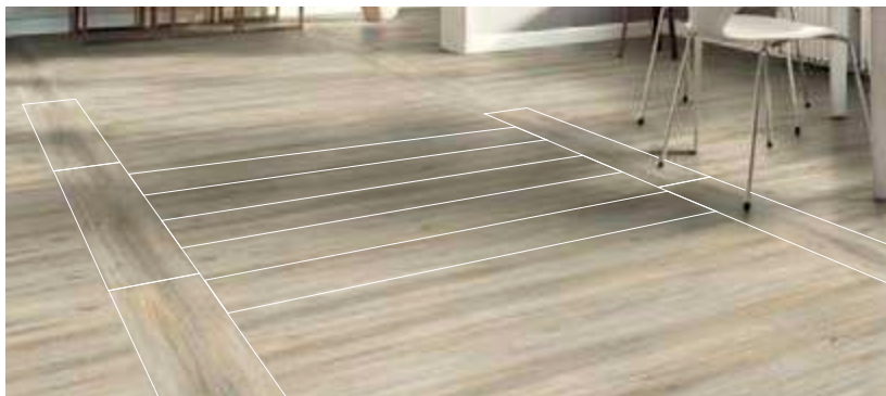
Leiterverlegung | Échelle | Tramline | Trapsgewijs gelegd N3
