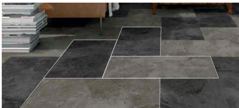
Fischgrätverlegung | Pose en bâton rompu | Herringbone | Visgraatpatroon P4 P6
